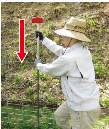
起こして垂直に仮打ちし・・・
